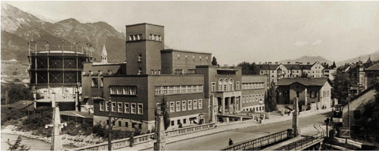
Hallenbad Amraser Straße um 1930
